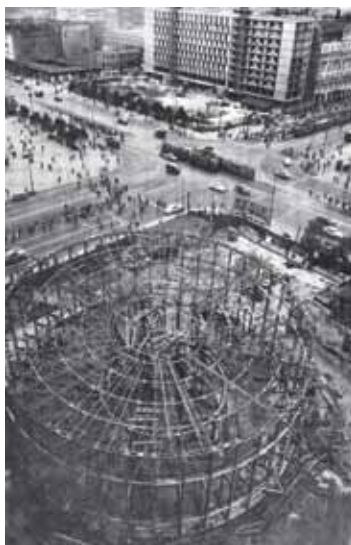
Budowa Rotundy PKO w Warszawie, fot. Wikipedia (domena publiczna).
